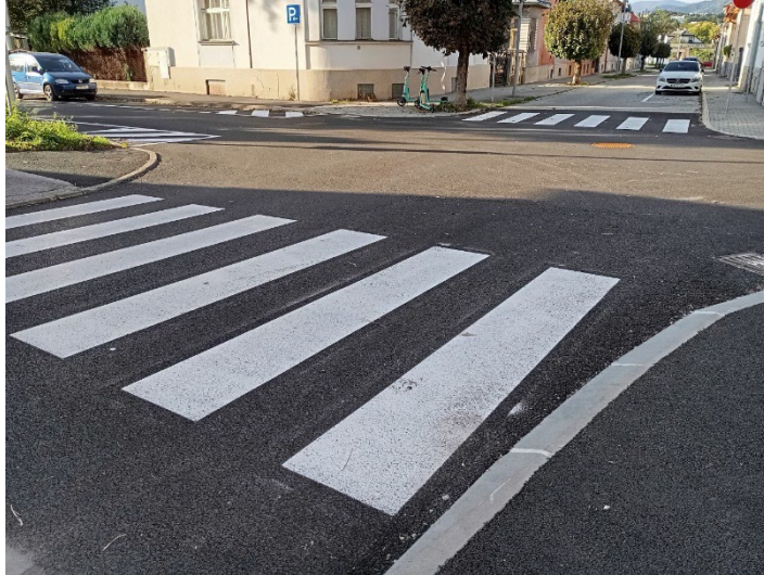
Obr.3: Nový asfaltový povrch, priechody pre chodcov a znížené obrubníky na ul. Na uhľisku.
